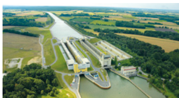
Esterholz – Schleuse Uelzen
